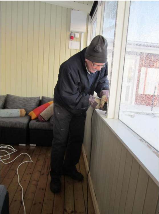
Janne förbereder fönsterbräderna av plåt, som skall förgylla uterummet i restaurangen.
