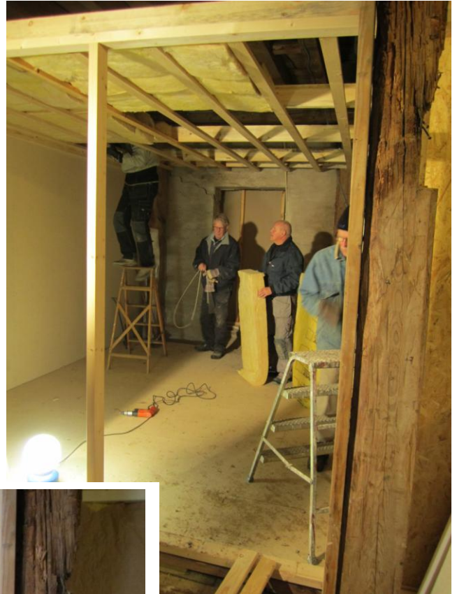
Här går det undan !! Isolering av tak och en rad gips på plats.
