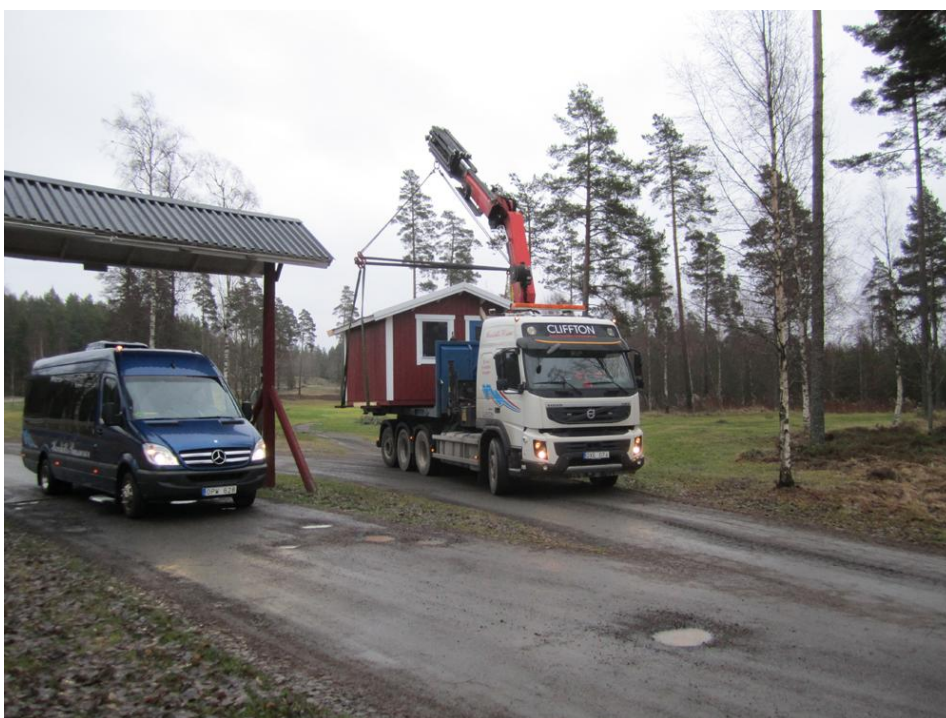
Tur att vägen är blockerad, annars hade vi fått bygga en ny portal också.
